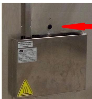
É normal o vapor da água em evaporação condensar nesta parte do evaporador
